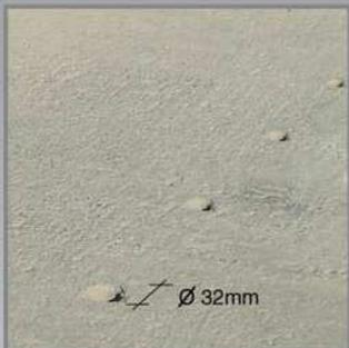
1. Realizar las perforaciones de un diámetro de 32 mm y una profundidad no inferior a los 400 mm.
