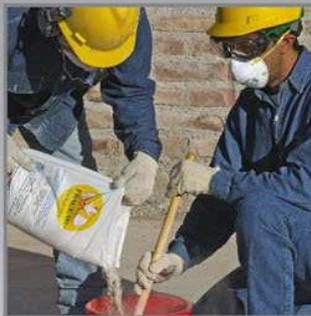
2. Viértase gradualmente el contenido de la bolsa de 5 Kg. en el recipiente con agua, luego mezclar hasta que se convierta en una pasta cremosa, fluida y sin grumos. La mezcla la puede realizar con un batidor o simple mezclador o inclusive manualmente con un trozo de madera. Es importante verter el producto en el agua y no viceversa.
