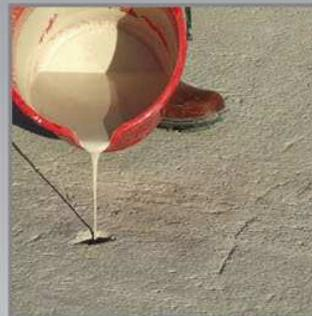
3. Colocar la mezcla en los orificios dentro de los 5 a 10 minutos posteriores a la mezcla. Este tiempo puede verse afectado por la temperatura ambiente y del agua (a mayor temperatura menor tiempo para colocar la mezcla en los orificios).
