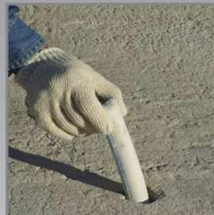
4. Introducir los cartuchos mojados en los orificios, uno por uno, y empújelos con una varilla (de madera) para que se adhieran perfectamente a las paredes de los orificios. Luego realice este mismo trabajo en los demás orificios.
