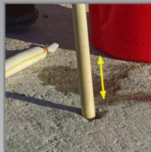
5. Asegúrese de que no hayan quedado espacios de aire entre los cartuchos o entre los cartuchos y las paredes de los orificios. El buen confinamiento de los cartuchos dentro de las perforaciones es clave para el funcionamiento del producto en esta versión.
