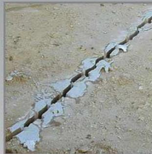
4. Manténgase alejado de los orificios y no los mire directamente hasta que haya pasado de 1 a 2 horas desde la colocación de la mezcla en los orificios, ya que es posible que ocurran algunas explosiones violentas o blow out.
